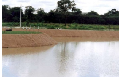
Foto 3 - Proteção de margens de rios e canais.
