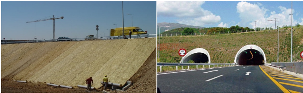
Foto 4 e 5 - Estabilização de taludes de terra para rodovias.
