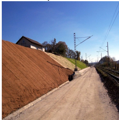
Foto 6 - Estabilização de taludes de terra para ferrovias.
